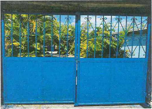
Foto 3: Mantenimiento de porton principal (limpieza, soporte y pintura)
