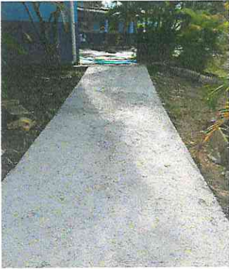
Foto 4: Sustitucion de rampa de ingreso de 2x3 de 8 cm de espesor.
