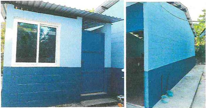
Foto 5: Colocación de pintura en aulas, cocina y baños.
