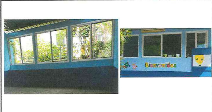
Foto1: Sustitucion de 03 ventanas tipo PVC corredizas con un alto de 1.71 mts por un ancho de 2.31 mts.
